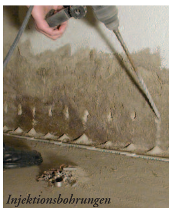
500 ml Silikonharz laufen je Bohrung ins Mauerwerk.
